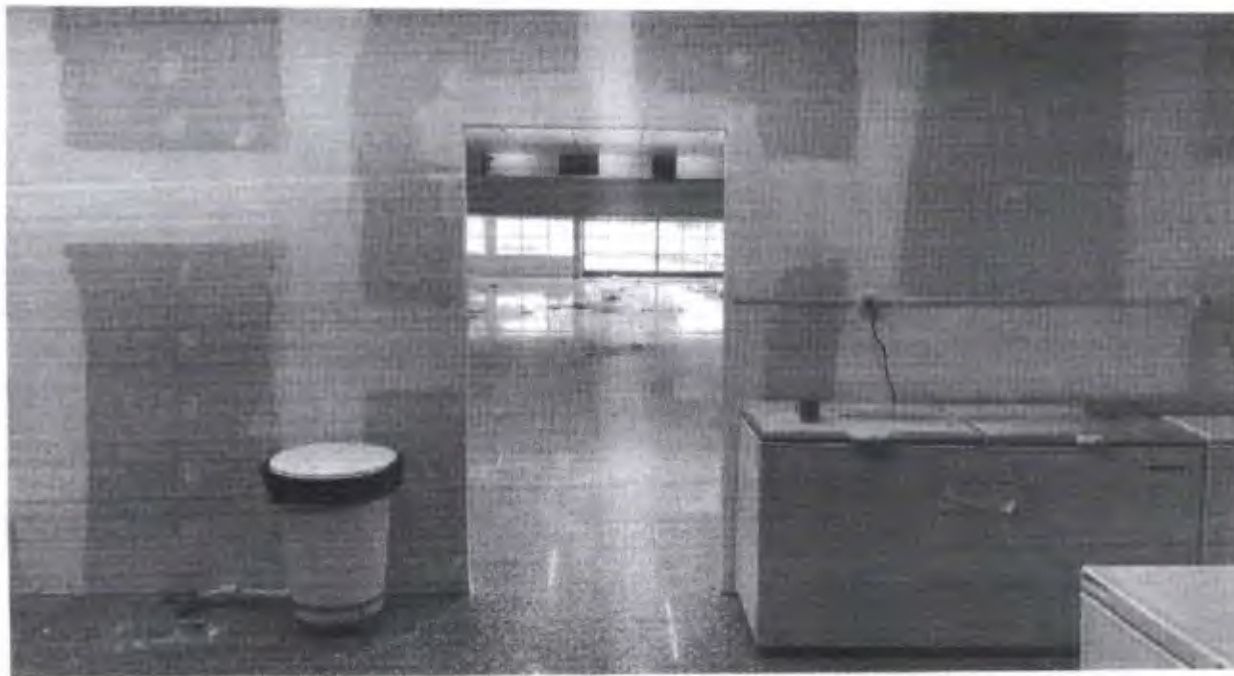
Figura 1 – PORTA – COZINHA PARA GALPÃO– COLOCAR BARREIRA FISICA OU PORTA E MANTER FECHADA. PINTAR TODA A ESTRUTURA COM TINTA BRANCA LAVÁVEL.
