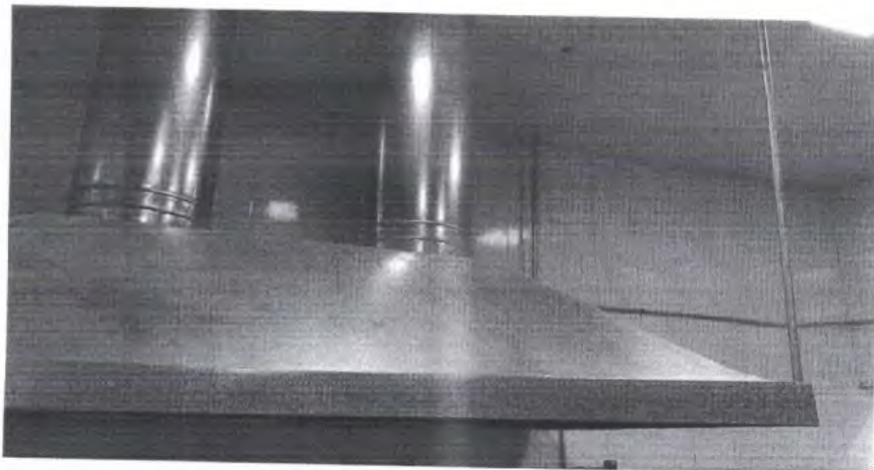
Figura 3- COIFA- PROVIDENCIAR MANUTENÇÃO. MUITO BARULHO.
