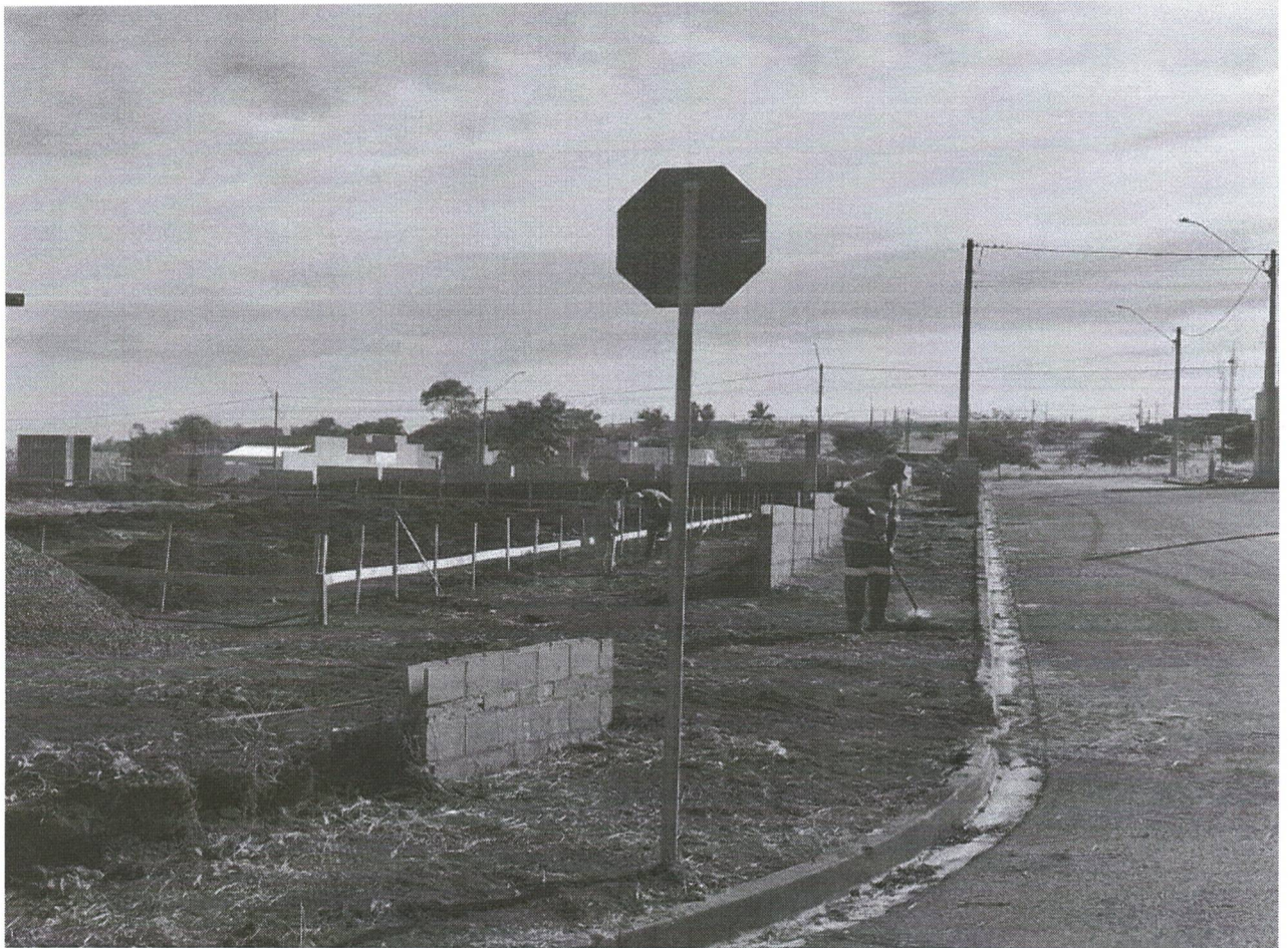
Foto 10 - Referente aos serviços de gabarito da obra e a escavação para realização das vigas baldrame.
