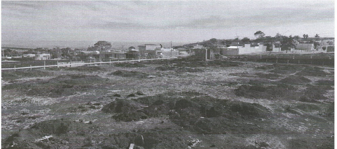
Foto 09 - Referente aos serviços de gabarito da obra e a escavação para realização das vigas baldrames.
