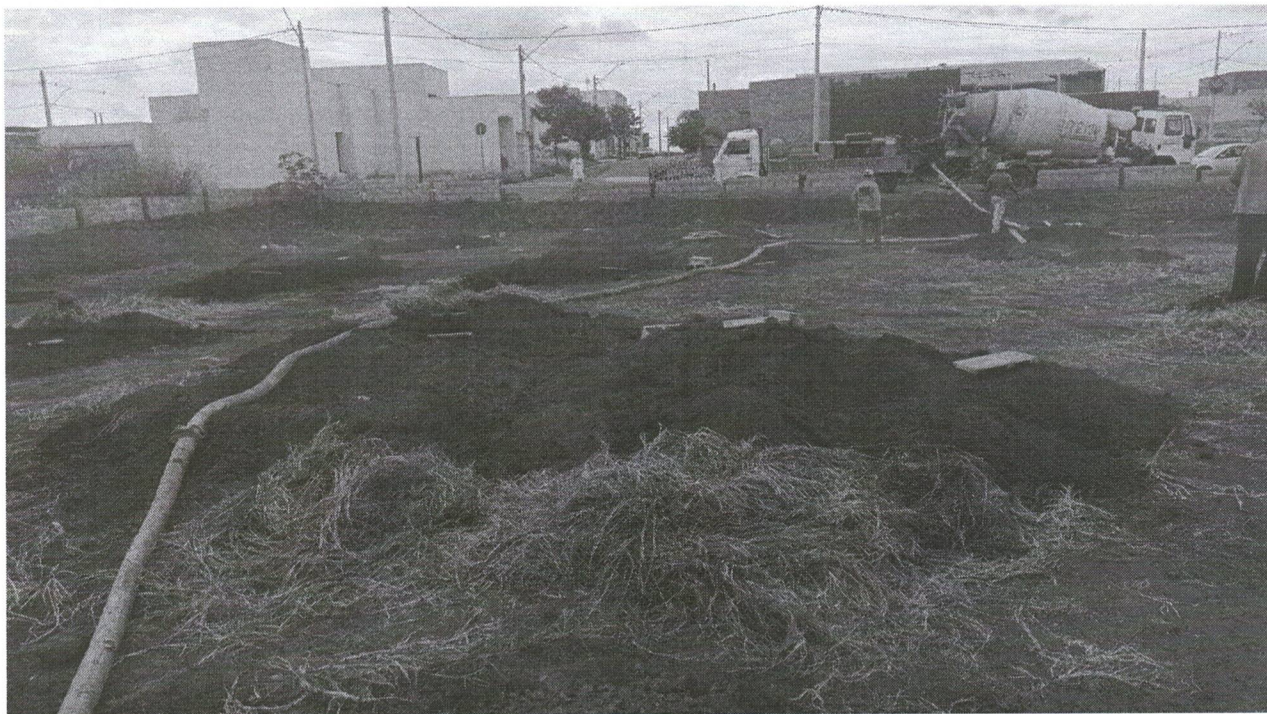
Foto 01 - Referente aos serviços de concretagem das estacas armadas escavadas com profundidades variando entre 7,5 metros e 13 metros de profundidade, com diâmetros variando de 0,30 m a 0,50 m.
