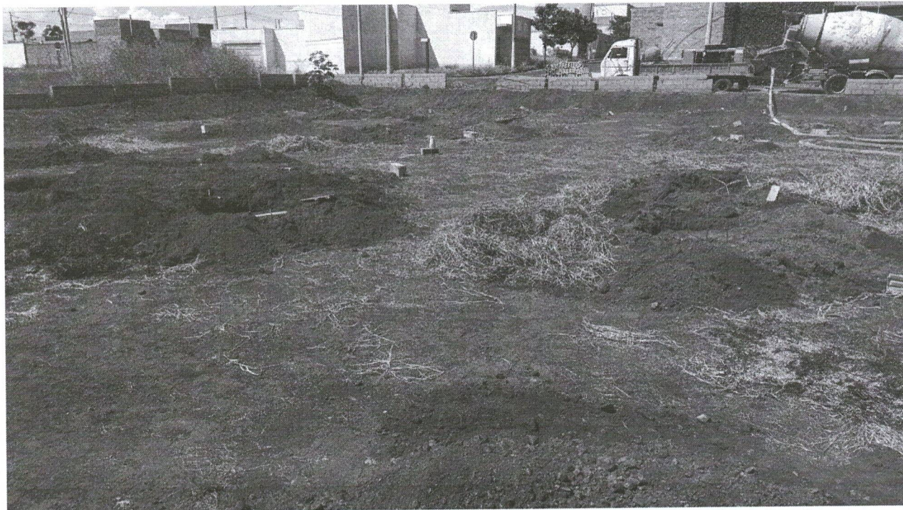
Foto 05 - Referente aos serviços de concretagem das estacas armadas escavadas com profundidades variando entre 7,5 metros e 13 metros de profundidade, com diâmetros variando de 0,30 m a 0,50 m.
