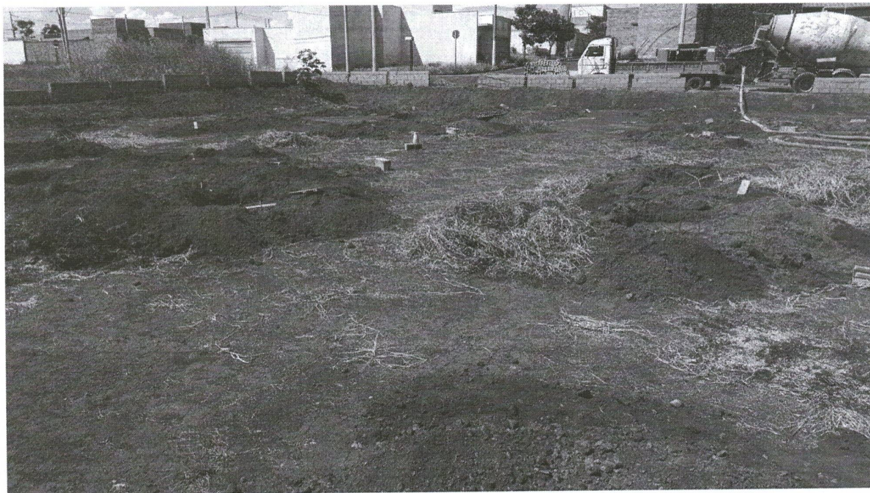
Foto 03 - Referente aos serviços de concretagem das estacas armadas escavadas com profundidades variando entre 7,5 metros e 13 metros de profundidade, com diâmetros variando de 0,30 m a 0,50 m.
