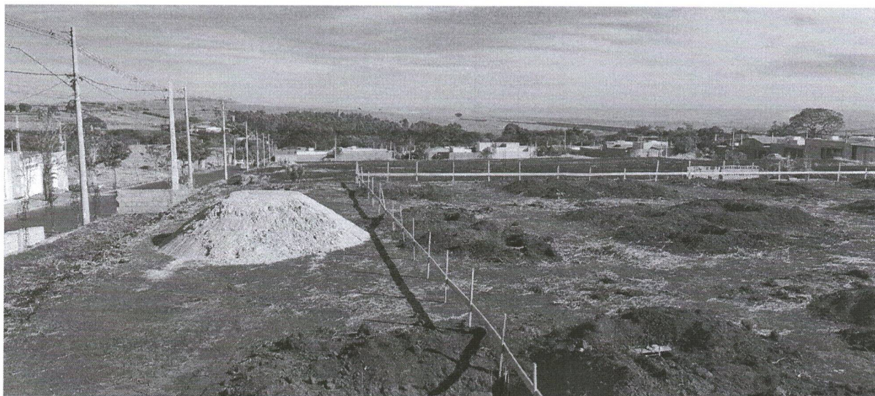
Foto 08 - Referente aos serviços de gabarito da obra e a escavação para realização das vigas baldrames.
